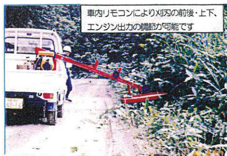
■軽トラック搭載型林道除草機による除草作業
